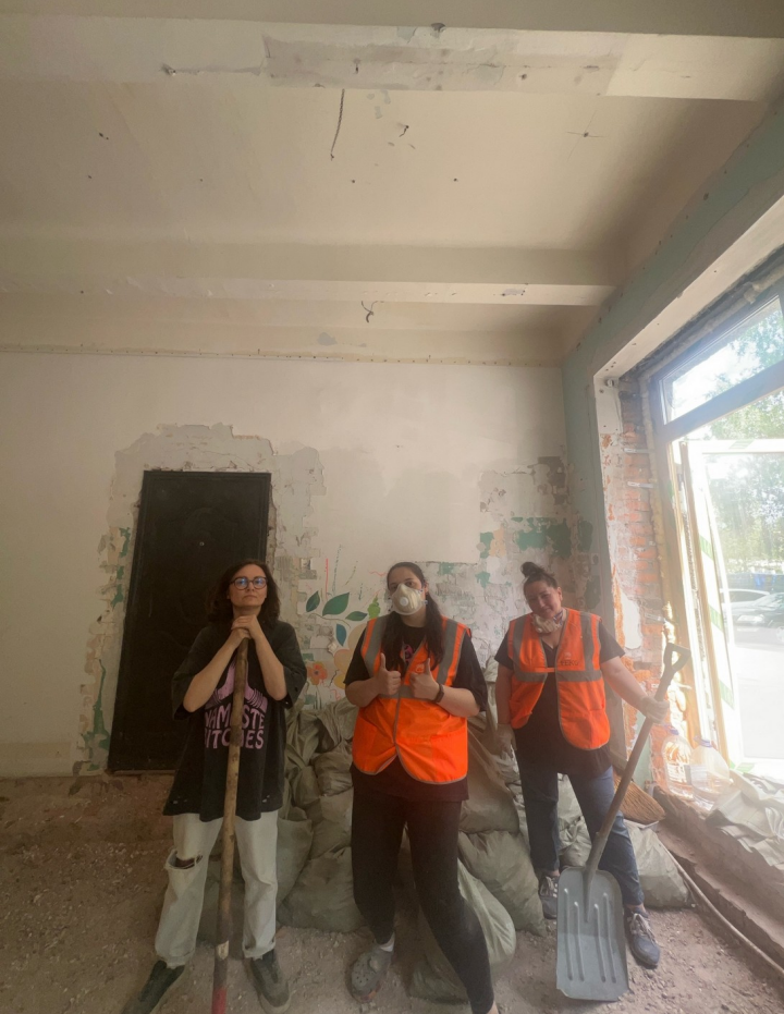
Команда фонда «Рекс» уже начала работу в помещении: демонтаж, установка окон и двери, вывоз строительного мусора
